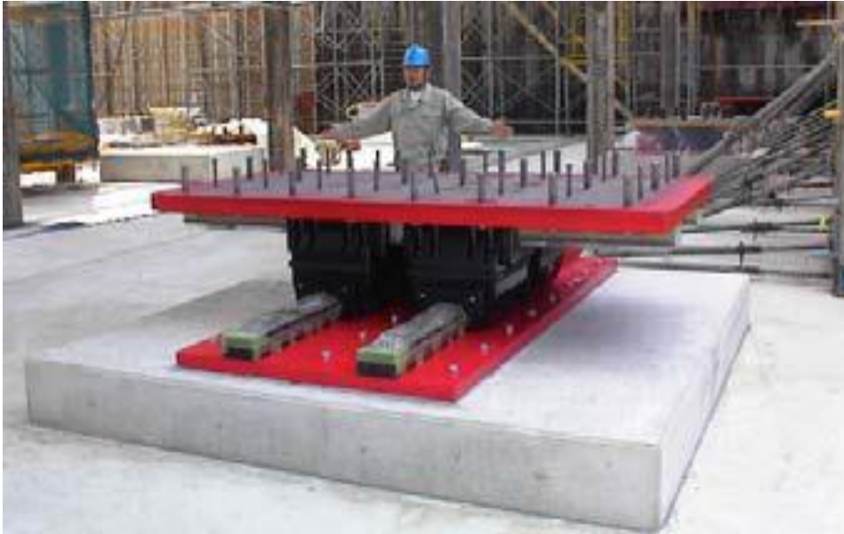
Şekil 5: Çapraz Doğrusal Hareket Sistemi (CLB) (Türker, 2005)
