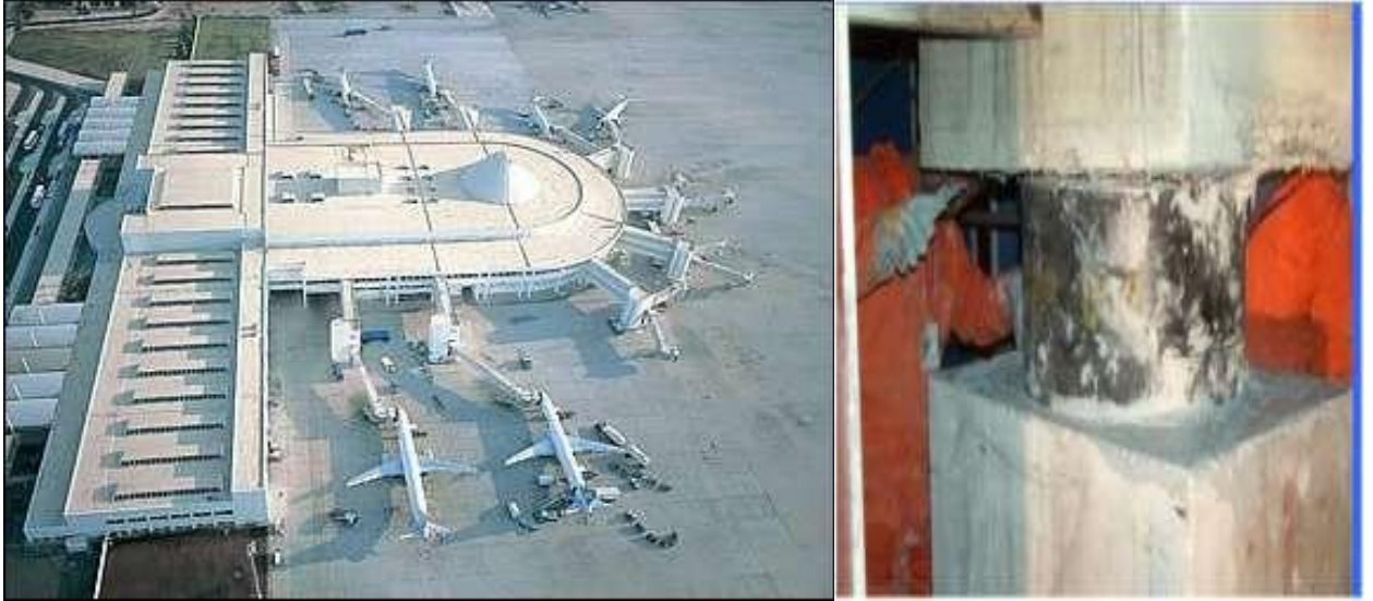
Şekil 12: Antalya Havaalanı Terminal Binası ve LRB Tipi İzolasyon Uygulaması
